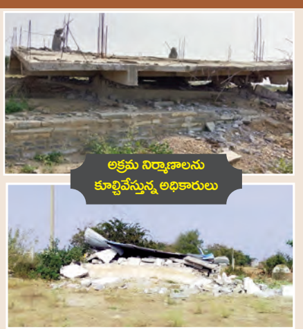
అక్రమ నిర్మాణాలను కూల్చివేస్తున్న అధికారులు
